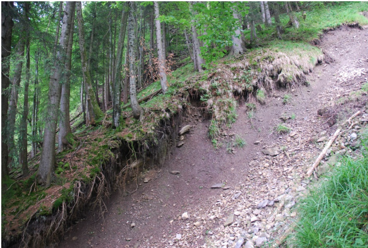
Best. 313, Tellenpfad. Unstabile Grabenkante mit mittlerem Baumholz bestockt. (Bild 2012)
